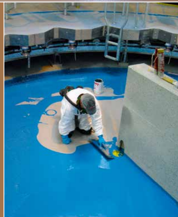
Einbau des Vencomat-Einstreubelages EPO
